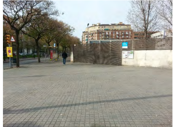
Entrada escola cantonada
