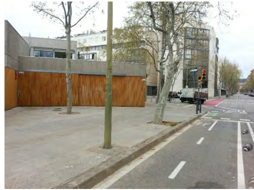
Entrada escola bressol Cobi
