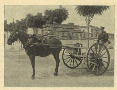
Máquina barrendera hipomóvil, reconstruída, con todo el herraje galvanizado  $\rightarrow$
