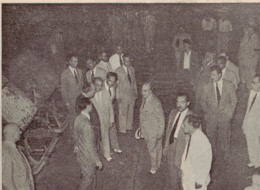
Visitando las obras de prolongación del Metro Transversal
