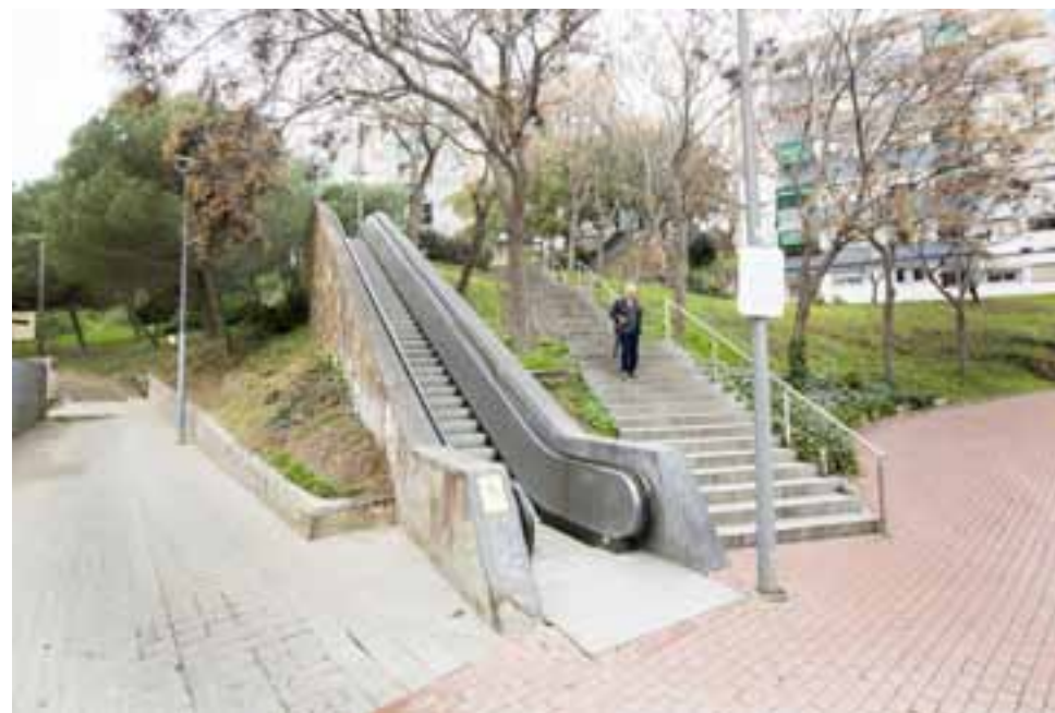
_Escales mecàniques i d'obra a l'avinguda dels Rasos de Peguera / Font: Ajuntament de Barcelona
