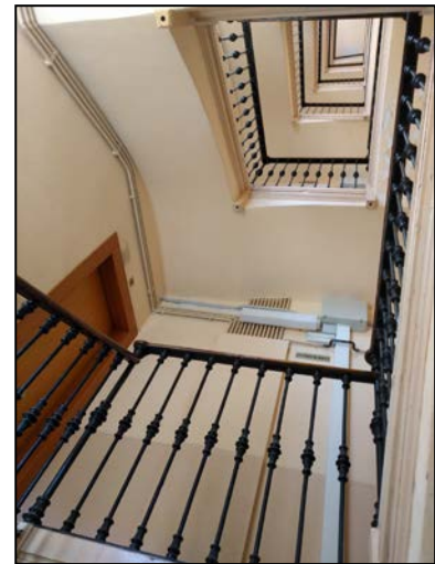
Forat d'escala apte per a ascensor
