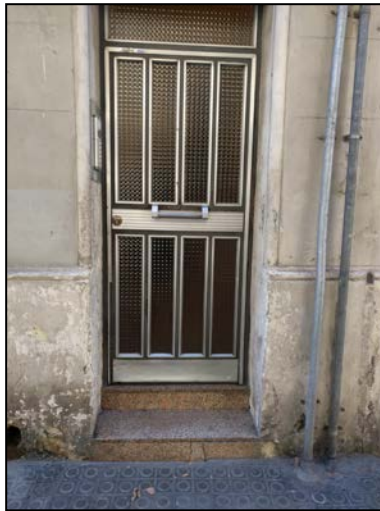
Doble graó exterior – interior
