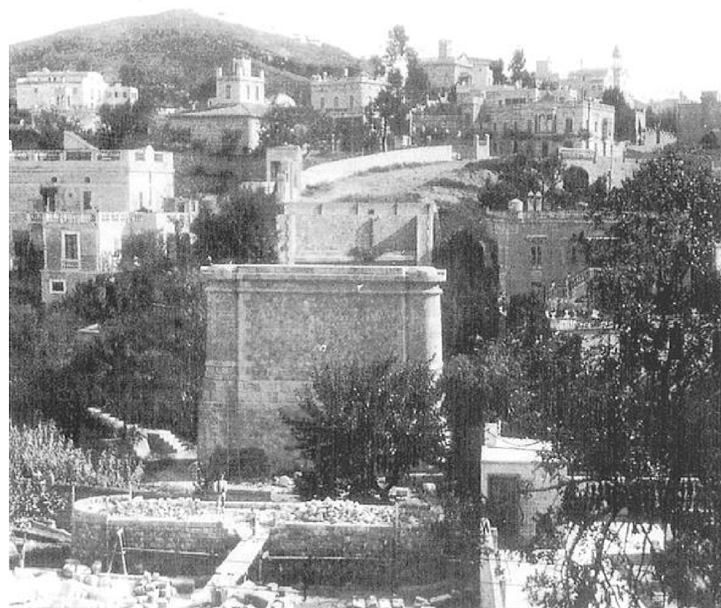
Figura 26. Fotografia del Viaducte de Vallcarca en construcció.
