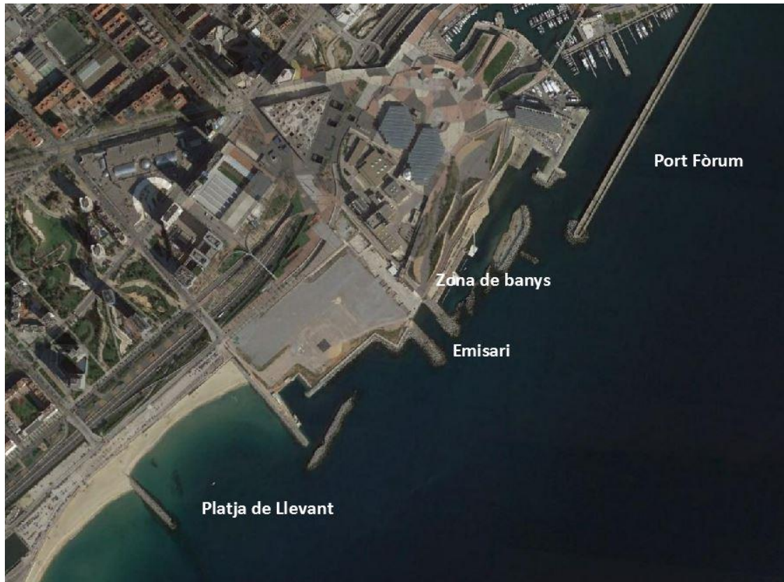
Figura 3 Descripció de la costa adjacent situada al sud del port
