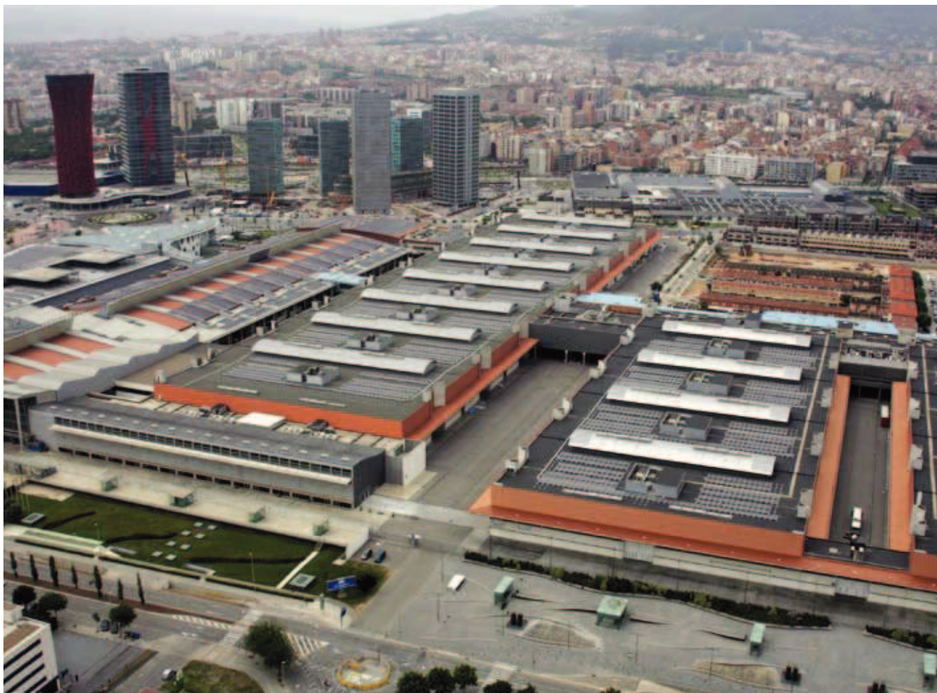
El recinte de Gran Via compta amb una de les plantes fotovoltaïques més grans del món sobre cobertes d'edificis
