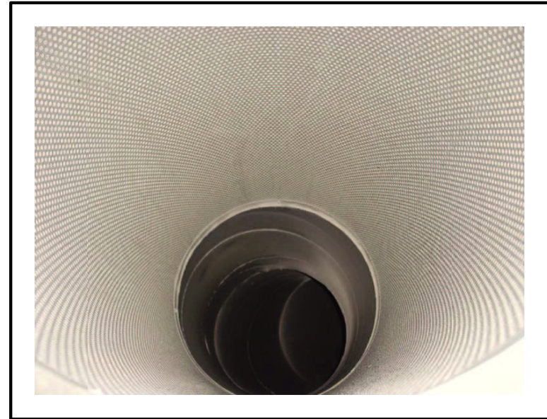
Canonada d'acer de \varnothing nominal =500 mm.
