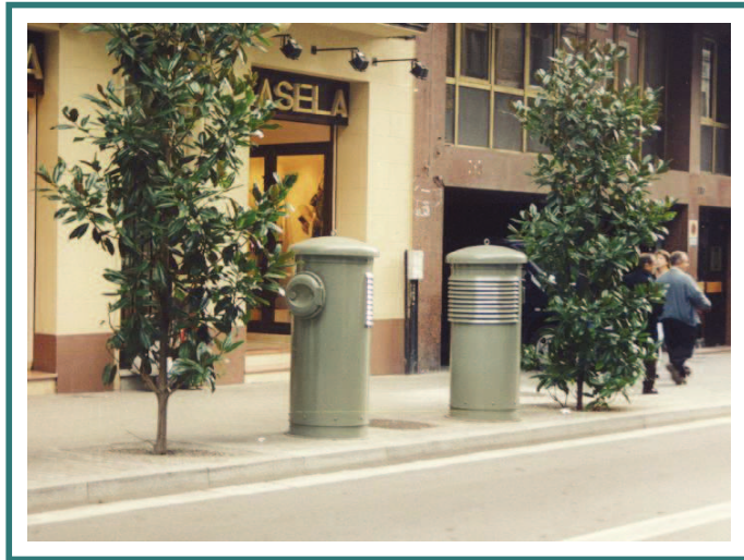
Bústies exteriors per a recollida domèstica, amb boca d'obertura de \varnothing = 30 cm.
