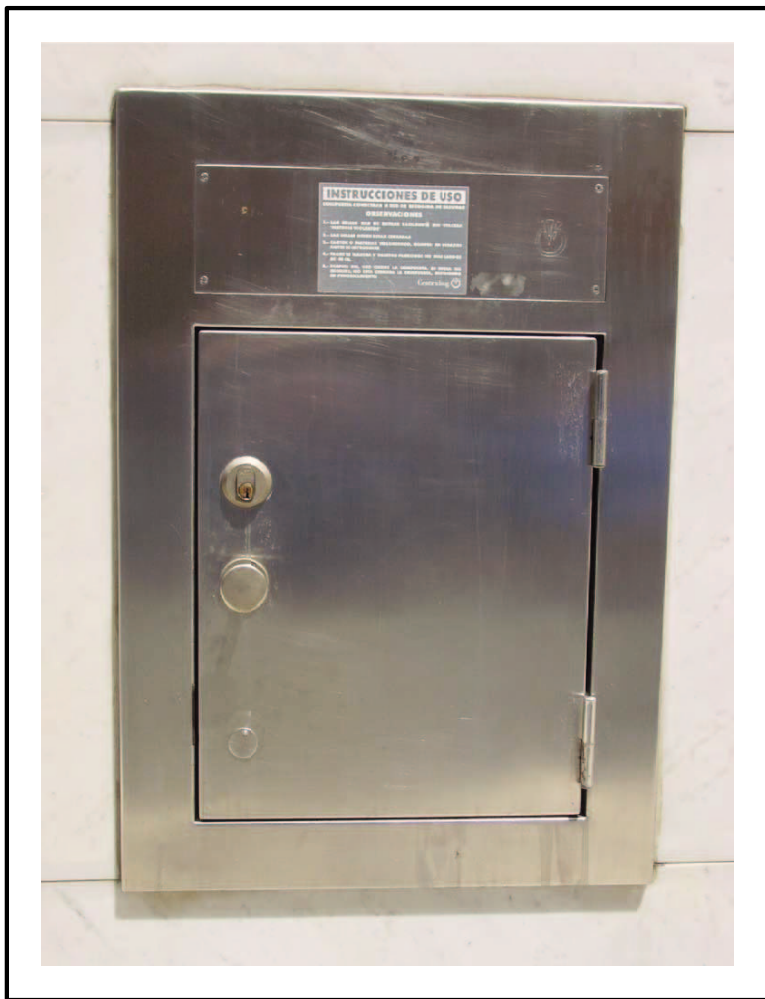
Comporta comercial tipus, de dimensions 40*60, amb pany i sensor de baixant ple.
