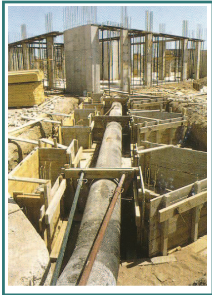
Instal·lació de tub per a xarxa general (col·locació en obra).
