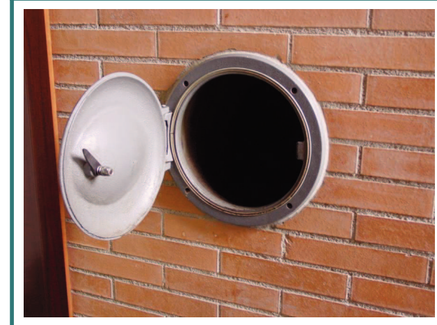
Comporta tipus domèstica, amb boca d'obertura de \varnothing = 30 cm.
