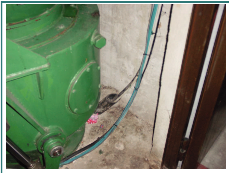
Sortida del conduit amb el tub d'aire comprimit i el cable de senyal.
