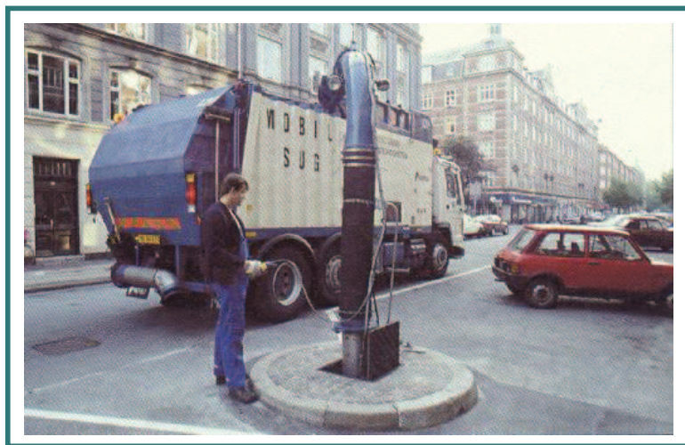
Extracció dels residus amb vehicle de succió, en sistema mòbil de recollida.
