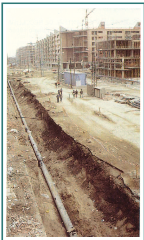
Instal·lació de tub per a xarxa general (col·locació en obra).
