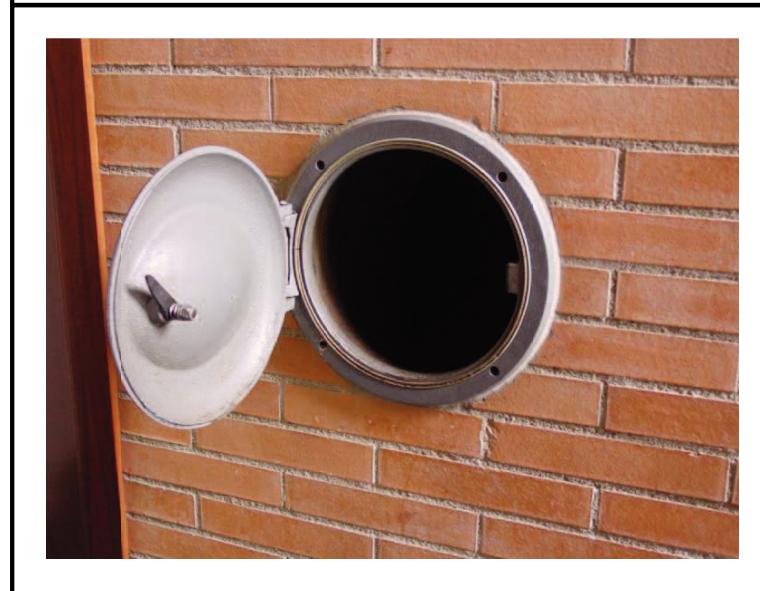
Comporta tipus domèstica, amb boca d'obertura de \varnothing = 30 cm.
