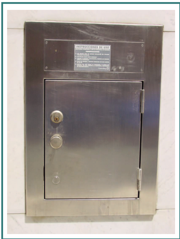
Comporta comercial tipus, de dimensions 40*60, amb pany i sensor de baixant ple.
