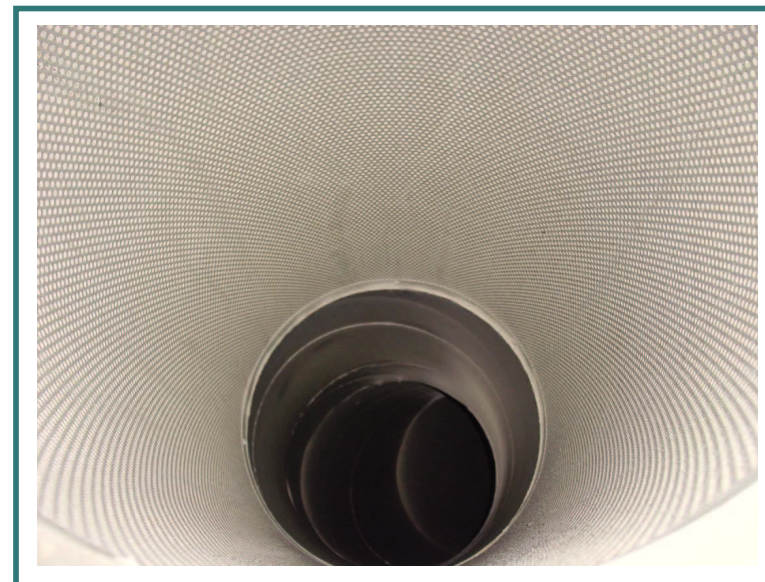
Canonada d'acer de \varnothing nominal =500 mm.
