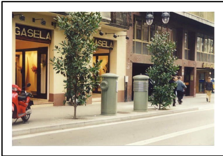
Bústies exteriors per a recollida domèstica, amb boca d'obertura de \varnothing = 30 cm.
