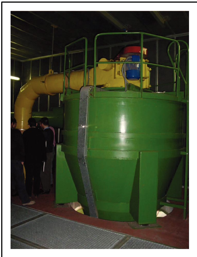
Cicló de separació aire-residu.
