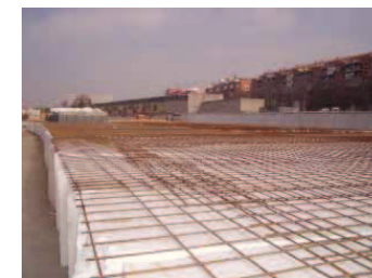
Reblert amb blocs de poliestirè expandit
