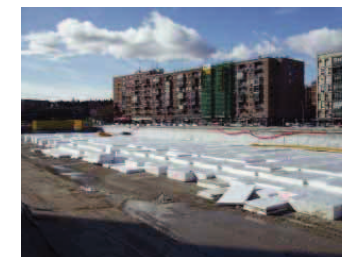
Preparació de capa de formigó armat sobre blocs de poliestirè expandit
