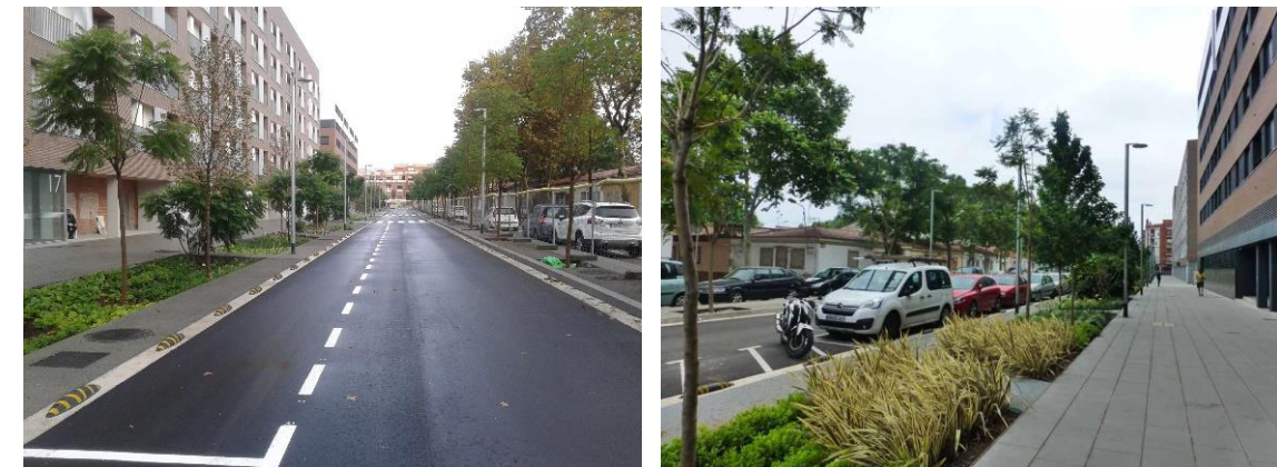
Figura 72: Imágenes de las franjas de biorretención de Bon Pastor (Fuente: Institut Municipal d'Urbanisme de Barcelona).
