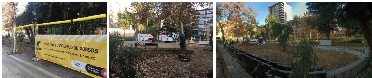
Figura 1: Obras de remodelación de los Jardines de Bacardí, diciembre 2017 (Fuente: Green Blue Management).
