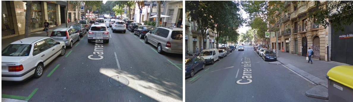
Figura 52: Calle Rocafort vista desde C/ València (izq.) y desde C/ Aragó (dcha.) (Fuente: Google Maps).
