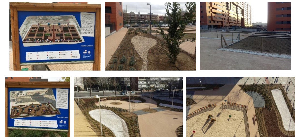
Figura 9. SUDS en las zonas verdes de la parcela sita en la intersección C/ Alfonso XIII - C/ Paraguai, Madrid (Fuente: Green Blue Management).
