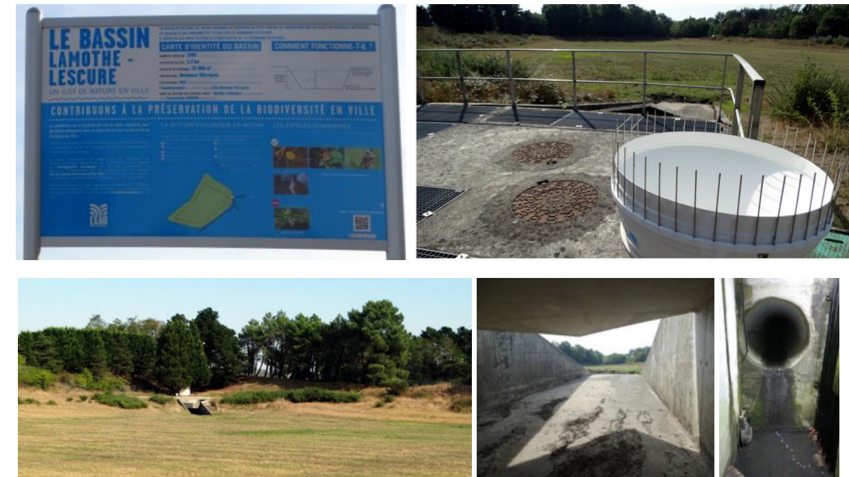
Figura 11. Cuenco de detención Le Bassin Lamothe-Lescure en Burdeos (Fuente: Par, 2017).
