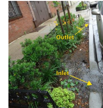
Figura 17. Franja de biorretención en Dean St. & 4th Ave. (Fuente: City of New York, 2012a).
