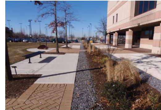
Figura 16. Jardín de lluvia y pavimento permeable en Queens College (Fuente: City of New York, 2014).
