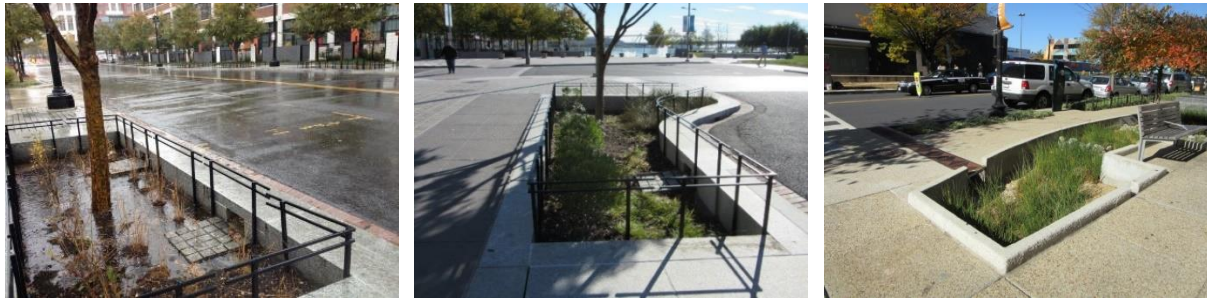
Figura 22. Franjas de biorretención en las calles de Washington DC (Fuente: Green Blue Management).
