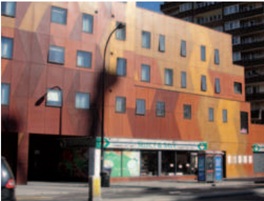
Foto 5: Edificio en Arch Street. Fotografía: Lenimar Arends, 2014.
