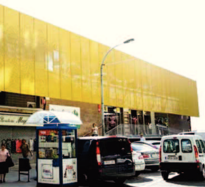
A dalt, imatges virtuals de l'exterior i l'interior de l'esborrany del projecte del nou Mercat del Bon Pastor. A l'esquerra i sobre aquestes línies, la façana, la nova façana del Mercat de Sant Martí i una de les parades. ➤ DESPATX D'ARQUITECTURA AA25. FOTO: PAU FABREGAT / IMMB
