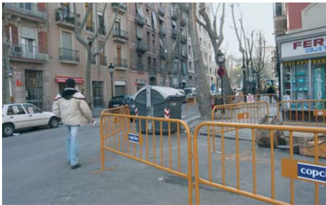
Obres de manteniment integral a un dels carrers.
