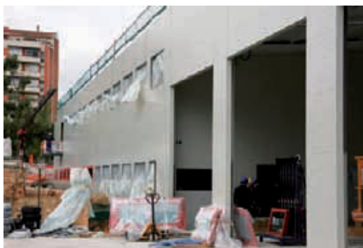
La caserna provisional del parc de Joan Miró, actualment en obres.
