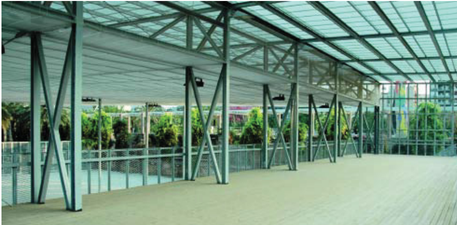
La nova zona polivalent, al principi de setembre, abans que s'acabessin les obres.
