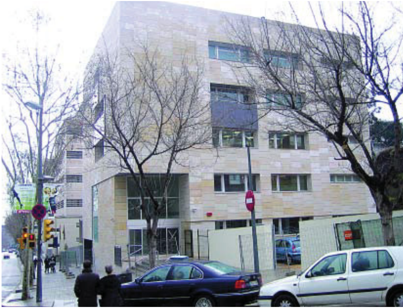
Aspecte de la nova seu de la Guàrdia Urbana a l'avinguda de Vallcarca.
