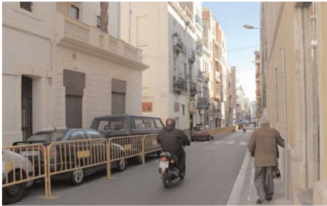
Obres de Manteniment Integral al carrer Torrent de les Flors.
