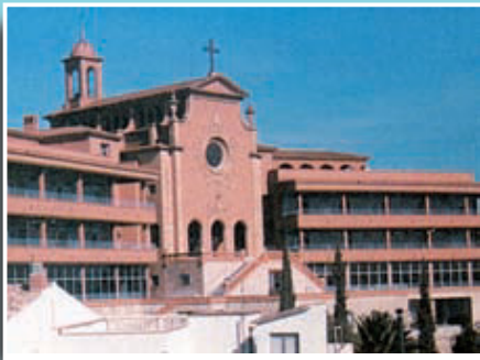
Imatge de la Torre del Suro al barri del Guinardó. (Foto: Arxiu Municipal del Districte d'Horta-Guinardó.)
