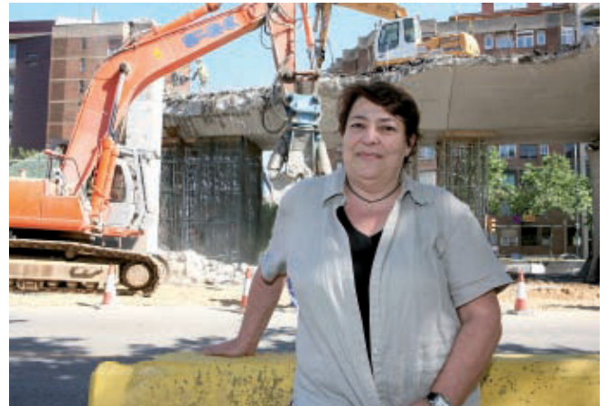
María Rodríguez posa davant del viaducte, en procés d'enderrocament.
