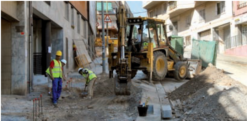
Obres d'ampliació de voreres al carrer Fastenrath.
