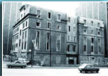
L'edifici de la clínica Victòria poc abans del seu enderrocament. (Foto: Taller d'Història Clot - Camp de l'Arpa.)
