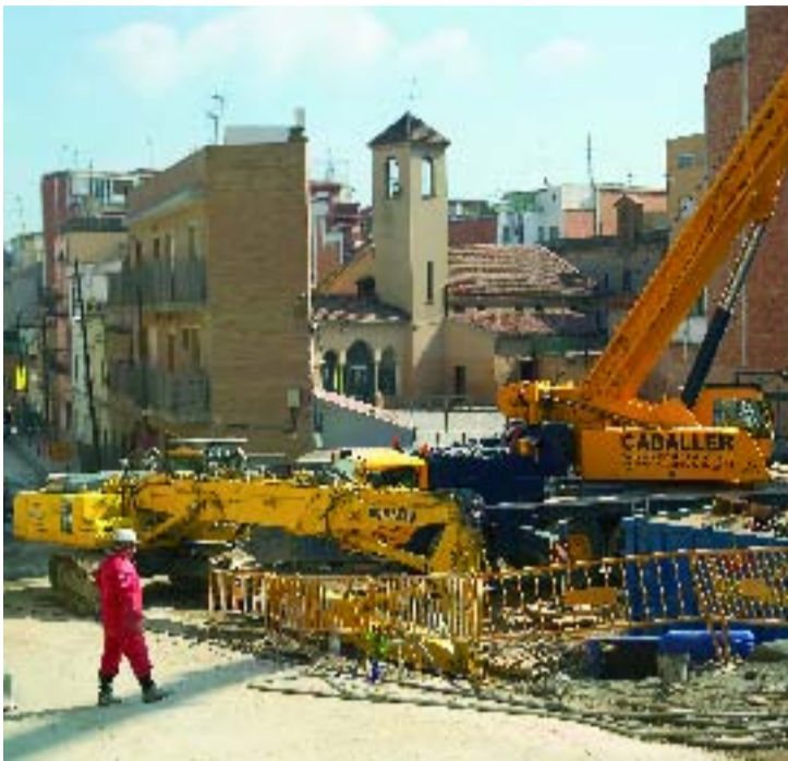
Les màquines segueixen amb les tasques d'enderrocament.
