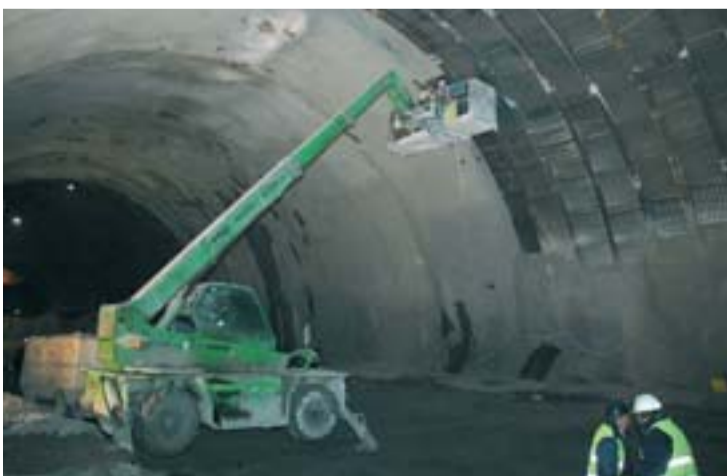
El túnel del metro es reforça (foto) mentre que el de maniobres que va causar l'esvoranc ha estat segellat.
