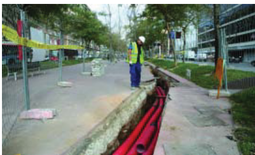
Les obres han començat pels treballs de desviament de serveis.
