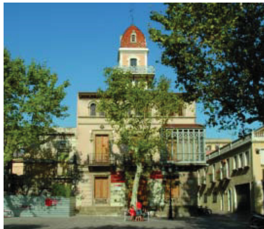
Façana del centre cívic Can Déu.
