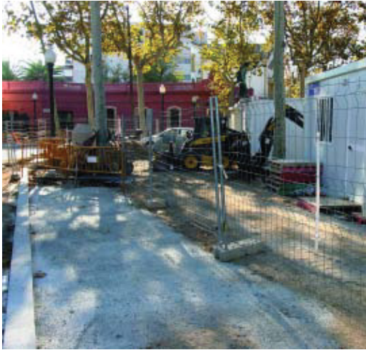
La plaça Pedralbes en ple procés de renovació.
