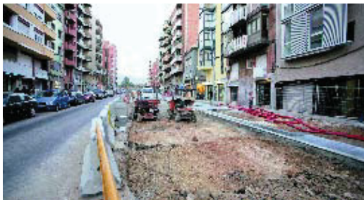
Obres al carrer de Sant Ramon Nonat.
