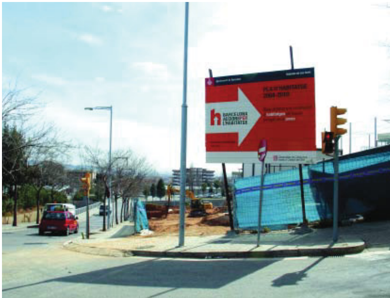
Les obres dels habitatges ja estan en marxa.
