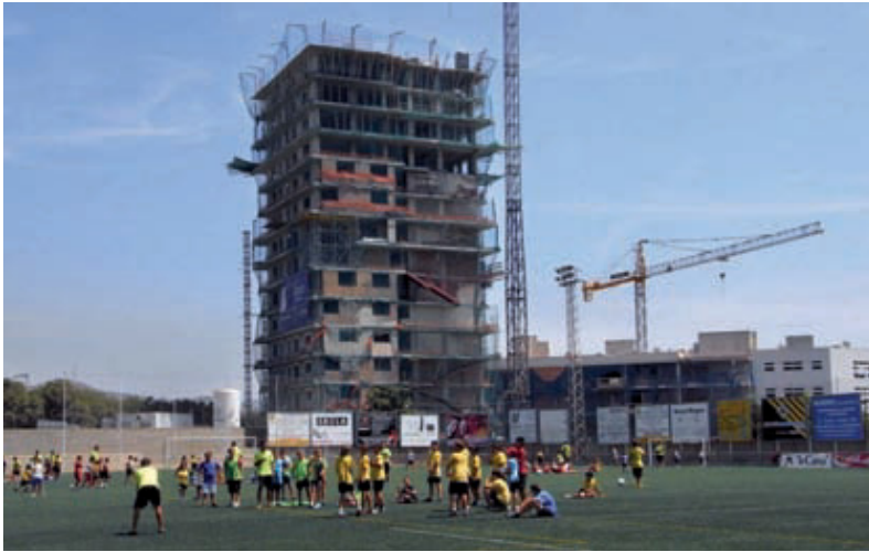
Bloc de pisos de protecció oficial en construcció a la Via Favència.
