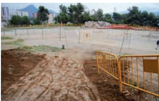
Estat actual de les obres al Campillo de la Virgen.
