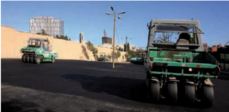
Obres d'adequació d'un aparcament al carrer Pintor Alzamora.
