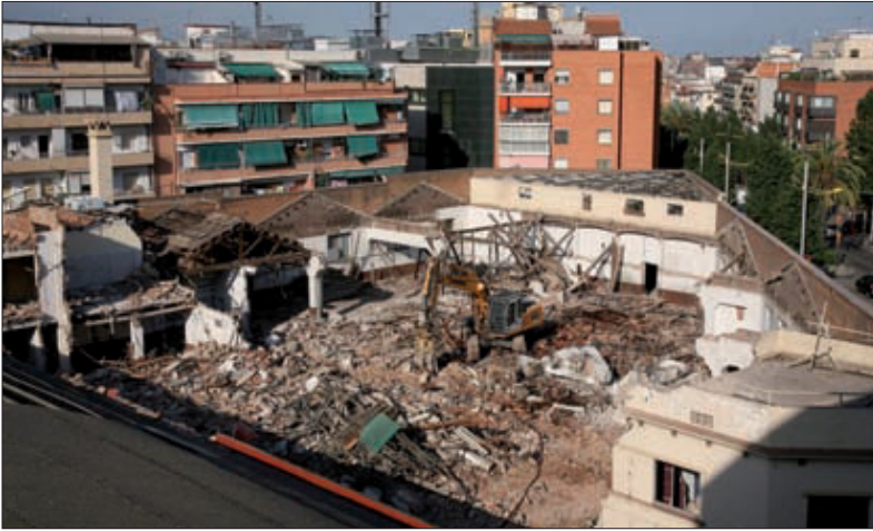
Obres d'enderroc de la fàbrica.
