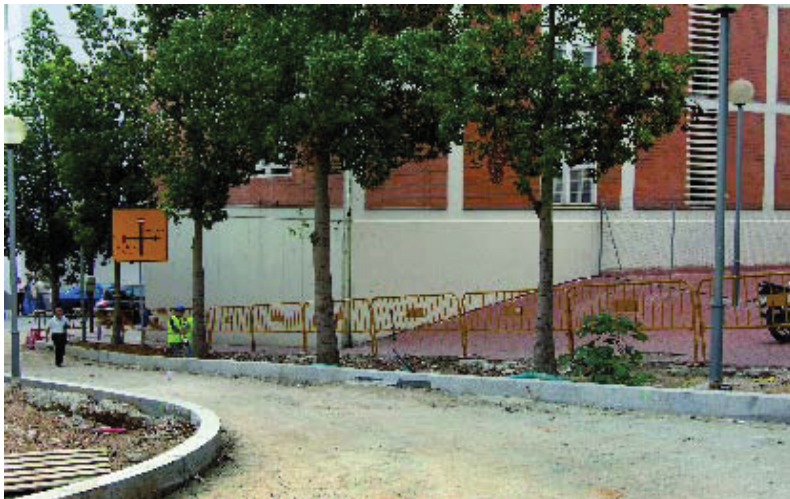
Obres al carrer Batllori.
