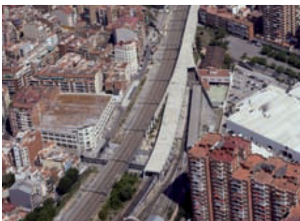
Panoràmica del tram viari cobert.
