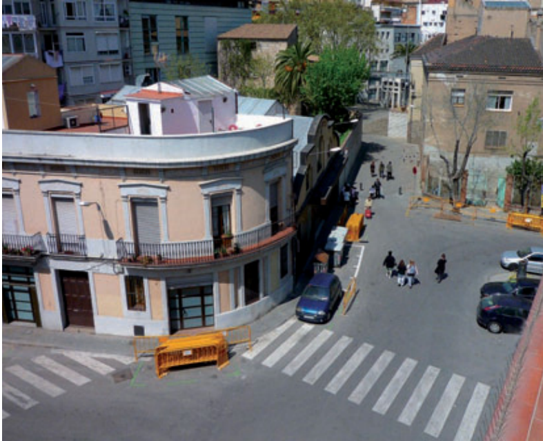
Vista de la plaça Ibèria, que també es reforma.
