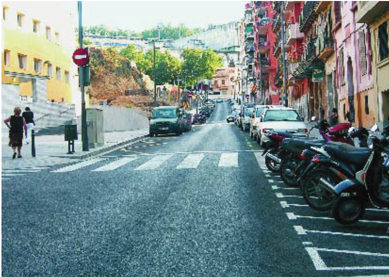
Els carrers s'estan remodelant i se suprimeixen les barreres arquitectòniques.
