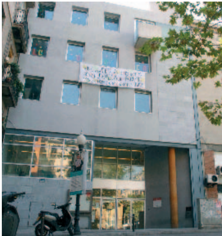
Façana principal del Centre Cívic el Sortidor al Poble Sec.
