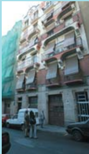
Una finca rehabilitada.
