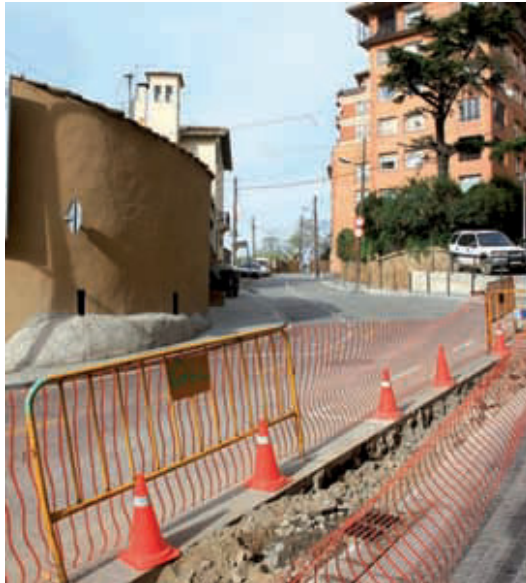
Imatge de les obres que s'estan fent al carrer Alberes.
