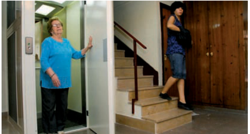
Un ascensor instal·lat a un edifici de Sarrià dins d'aquesta campanya.
