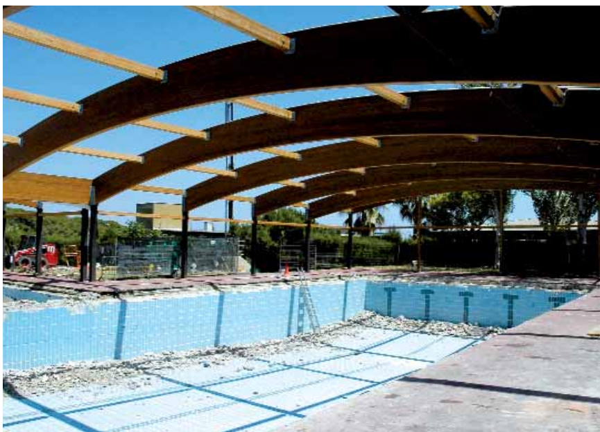
La piscina tindrà un nou tractament d'aigua amb sistema de raigs ultraviolats.
