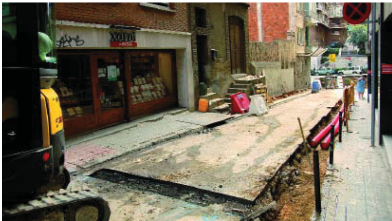
Al carrer del Berlinès es renovarà integralment el cablejat, es crearàn nous embornals, entre altres actuacions.
