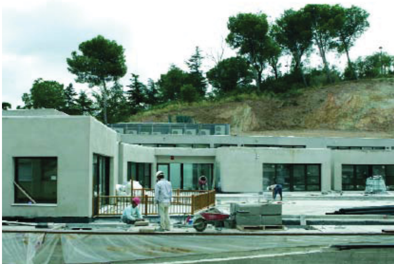
La nova escola El Putget encara en obres a final del mes d'agost.
