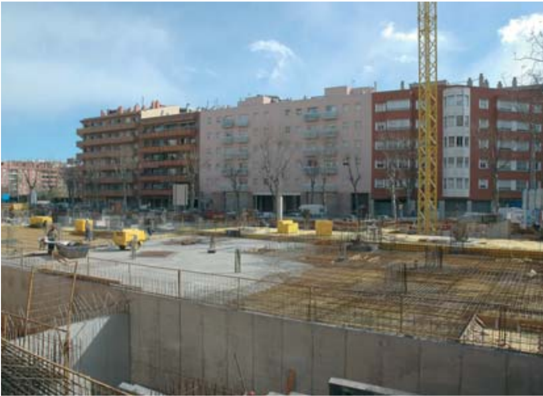
Les obres de l'illa d'equipaments i serveis públics ja han començat.
