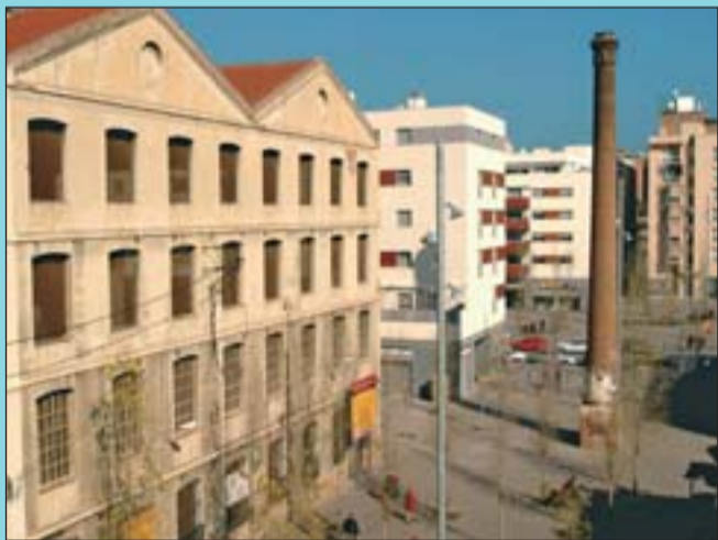
Ara L'indret ha canviat molt, el carrer Joncar pràcticament ha desaparegut i la façana espera la rehabilitació.
