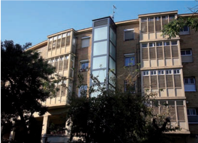
Nou ascensor instal·lat a la façana d'un edifici del carrer Pardo.
