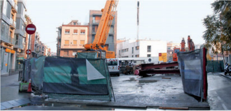
Les obres a la plaça de les Havaneres.
