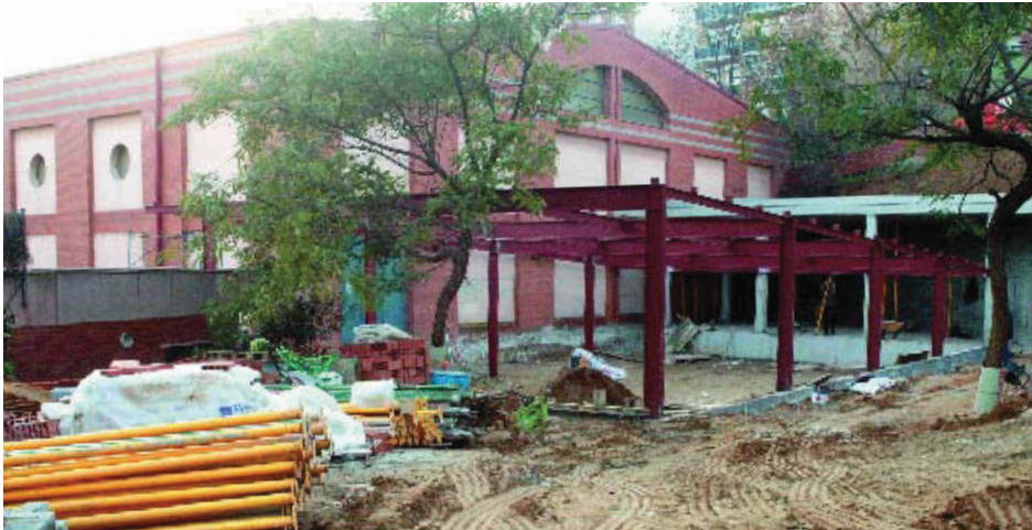
Obres a les instal·lacions del CEM Trinitat Vella.
