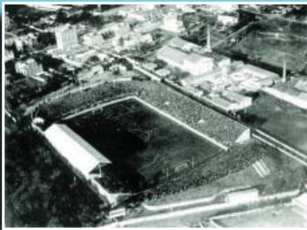
Imatge aèria del vell camp de les Corts el 1925. (Foto: Arxiu Fotogràfic Gaspar - AHCB-AF)
