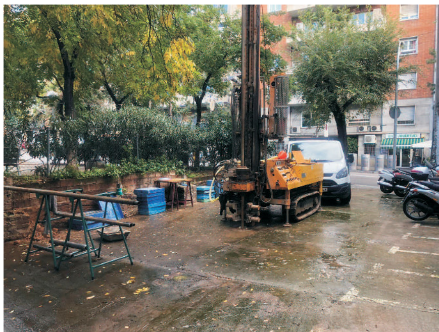
Fotografia 12. Execució del sondeig S-3R.
