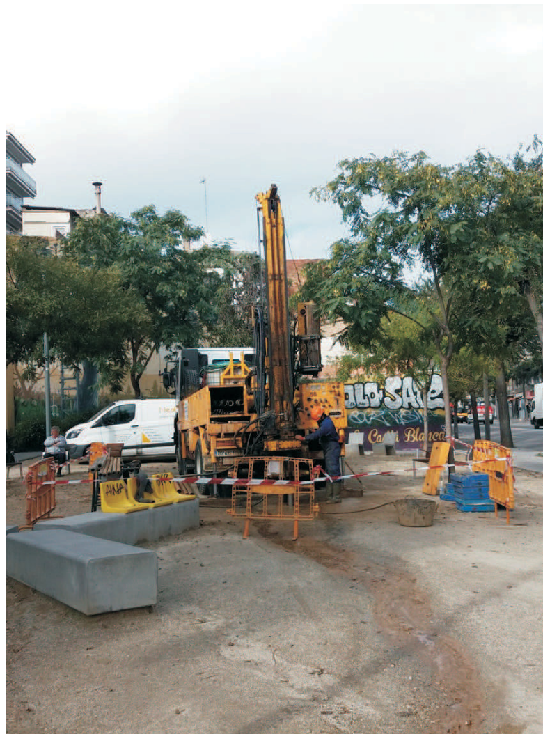
Fotografia 11. Execució del sondeig S-2R.
