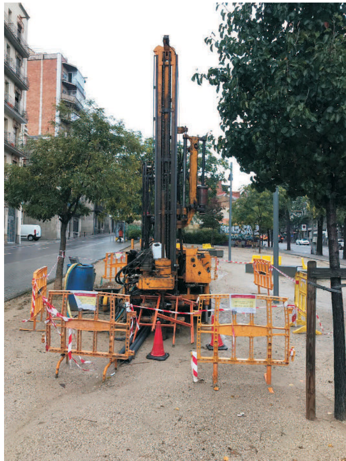
Fotografia 10. Execució del sondeig S-1R.
