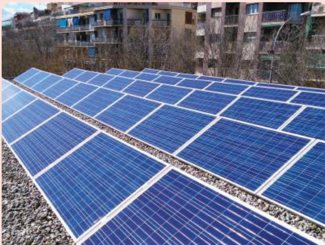
Mejora de la eficiencia energética
