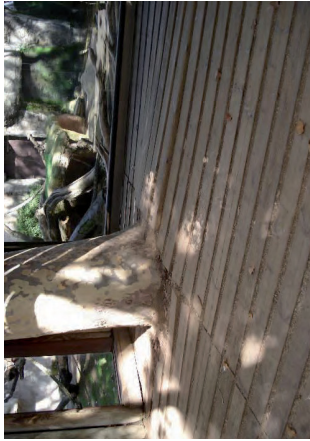
Condicionament d'accés a mirador, adequant les fustes i complint normativa d'accessibilitat.
