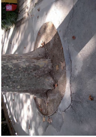
Millora dels escocells, adaptant-los a la cota dels vials..
