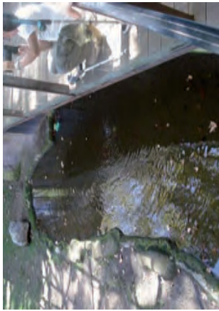
Repicat en el got per instal·lació de canonades d'impulsió i absorció dins del llac.
