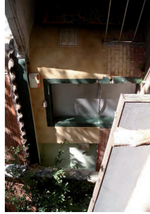
Adequació de l'entrada a la instal·lació, amb barana de protecció i terra antilliscant.
