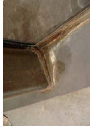
Decapat de tanques i posterior aplicació d'imprimació i pintura.
