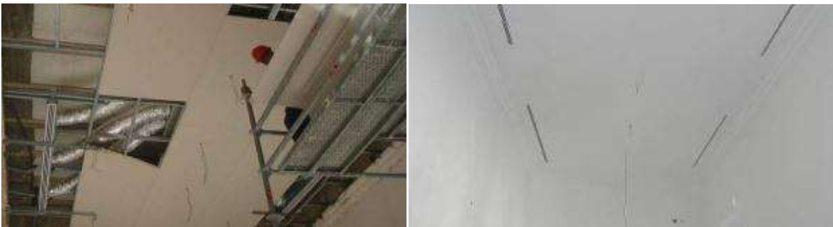
Colocación de falsos techos
