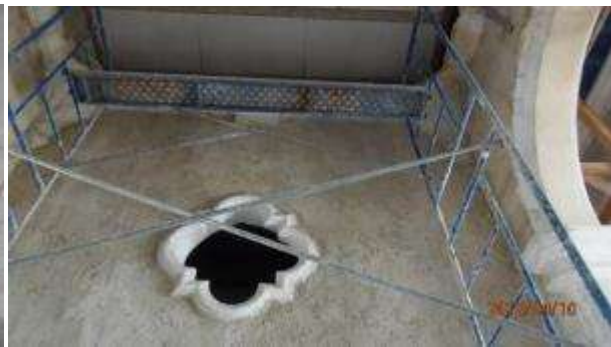
Demolición de estructuras horizontales en mal estado
