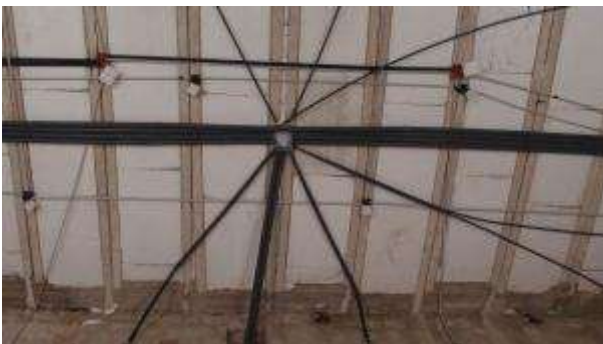
Colocación de electricidad y estructura soporte de falso techo
