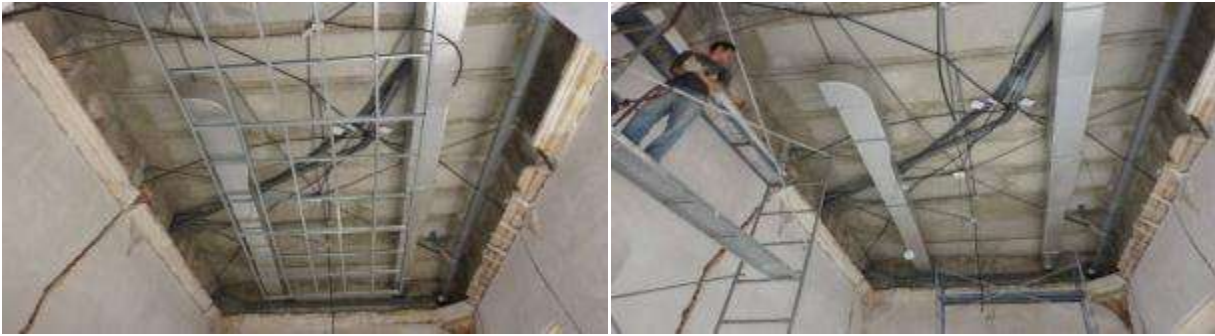
Colocación de conductos del clima
