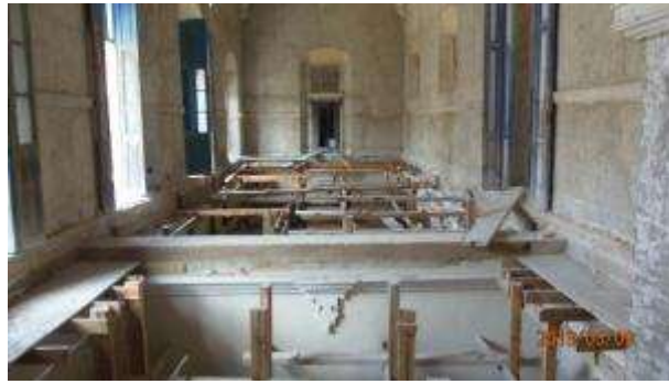
Demolición de estructuras horizontales en mal estado
