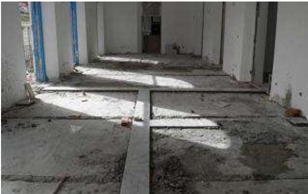
Fundición de un prepiso de hormigón celular y colocación de terminaciones de piso en la planta superior
