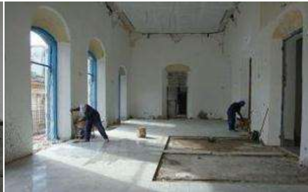
Fundición de un prepiso de hormigón celular y colocación de terminaciones de piso en la planta superior
